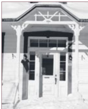
Figure 32 Porte avec imposte vitrée.
