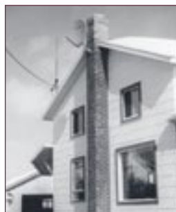
Figure 63 Massif de cheminée construit à l'extérieur.
