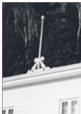
Figure 75 Mât au sommet d'une corniche.
