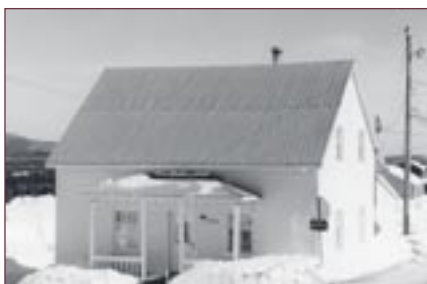
Figure 21 Toiture en tôle profilée.
