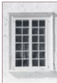
Figure 34 Fenêtre à battants à petits carreaux.
