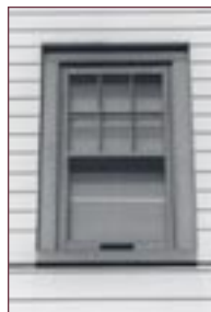
Figure 37 Fenêtre à guillotine.
