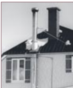
Figure 62 Deux générations de cheminées.
